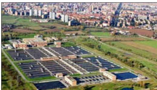
Il depuratore di Milano Nosedo e, sullo sfondo, la città di Milano.
